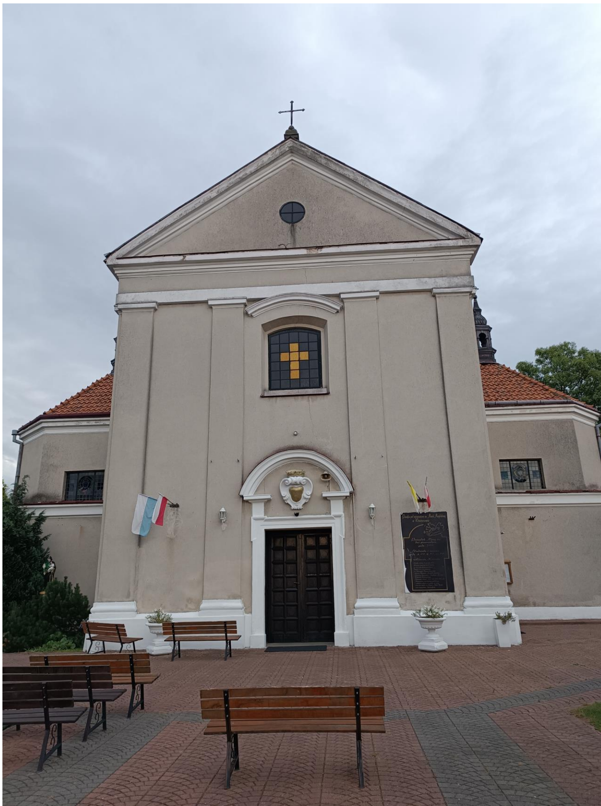
(zdjęcie nr 9– Elewacja frontowa kościoła)
